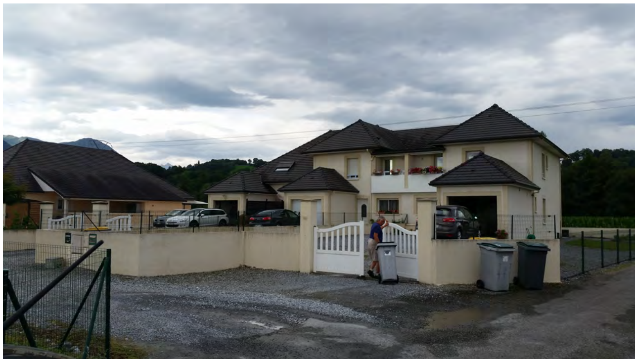
constructions maisons jumelées récentes
