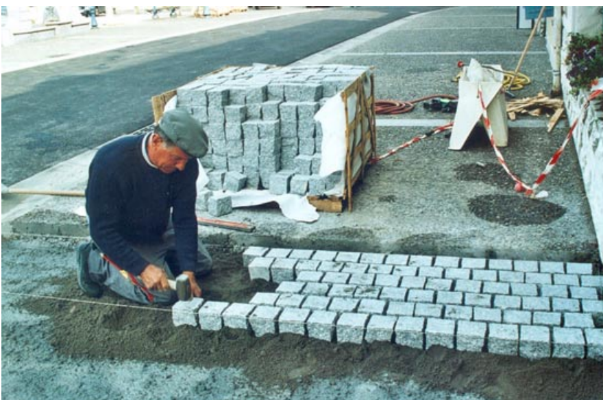
Photo (Jutta Peyrounat) : Pose des pavés
