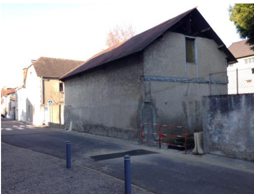
Entrée des locaux face à la mairie
