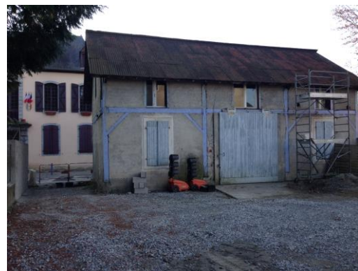
Le hangar en cours d'aménagement
